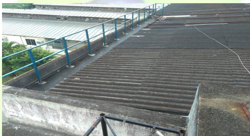
Figura 5: Telhado ainda em telhas de fibrocimento que cobre a laje que deverá ser impermeabilizada
